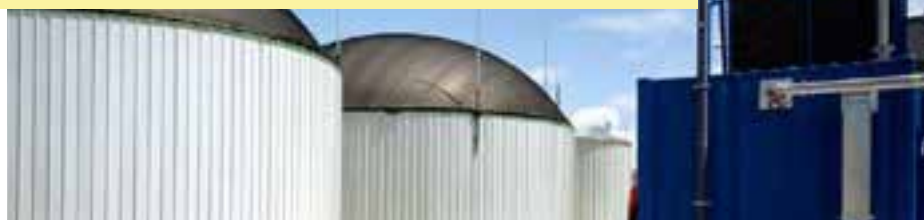
Impianto per la produzione di biogas
