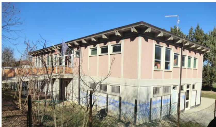
Vista dell'edificio dal Viale della Stazione
