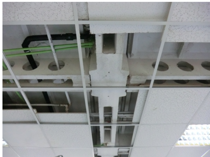
Rimozione controsoffitti intradosso primo solaio
