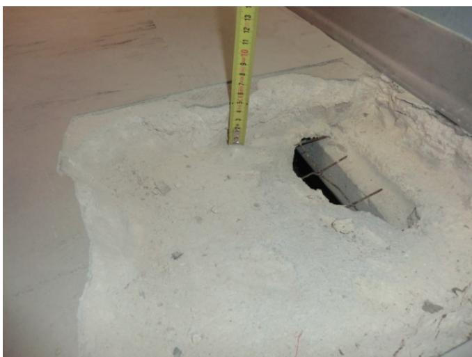
Saggio solaio piano terra
