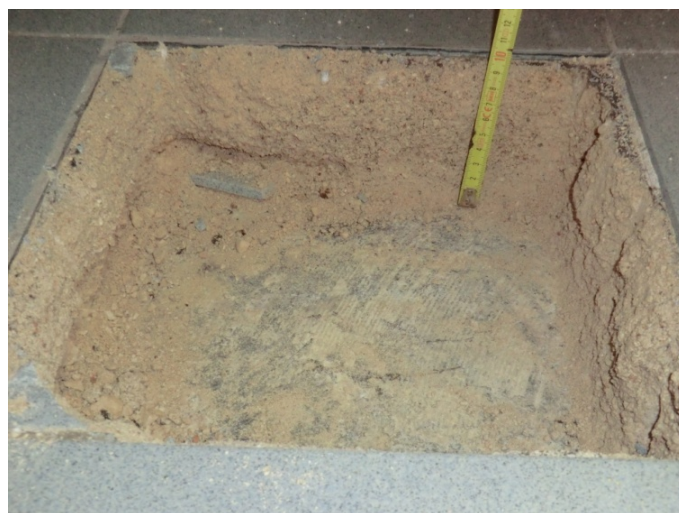
Saggio solaio piano primo
