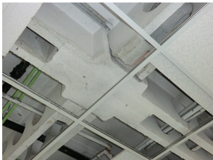
Rimozione del copriferro su trave secondaria
