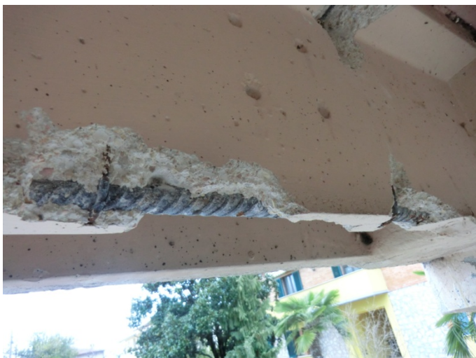
Rimozione del copriferro su trave principale
