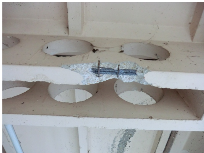
Rimozione del copriferro su trave secondaria
