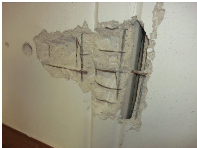
Rimozione del copriferro su trave principale
