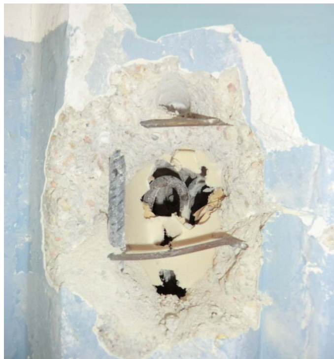
Particolare uncini armature lisce di completamento non gettate
