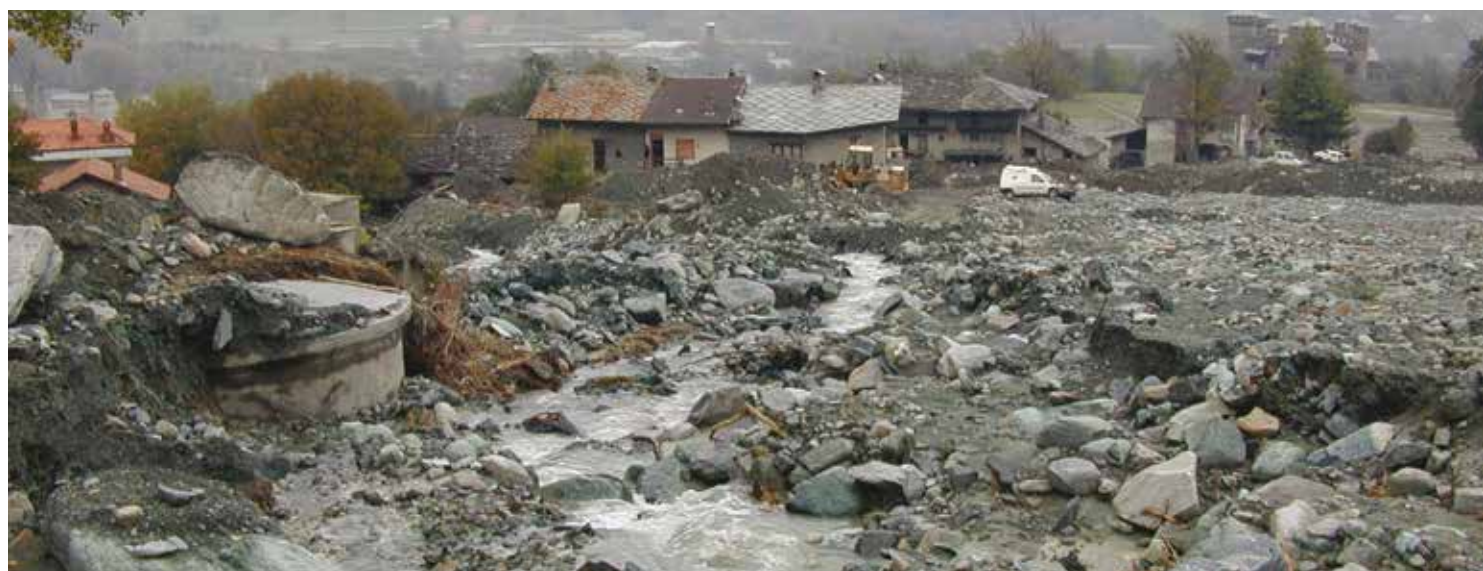
Foto 8.10 Abitazioni investite da una colata di detriti Frazione di Pléod Fenis [AO] Fonte ISPRA Benedetto Porfidia
