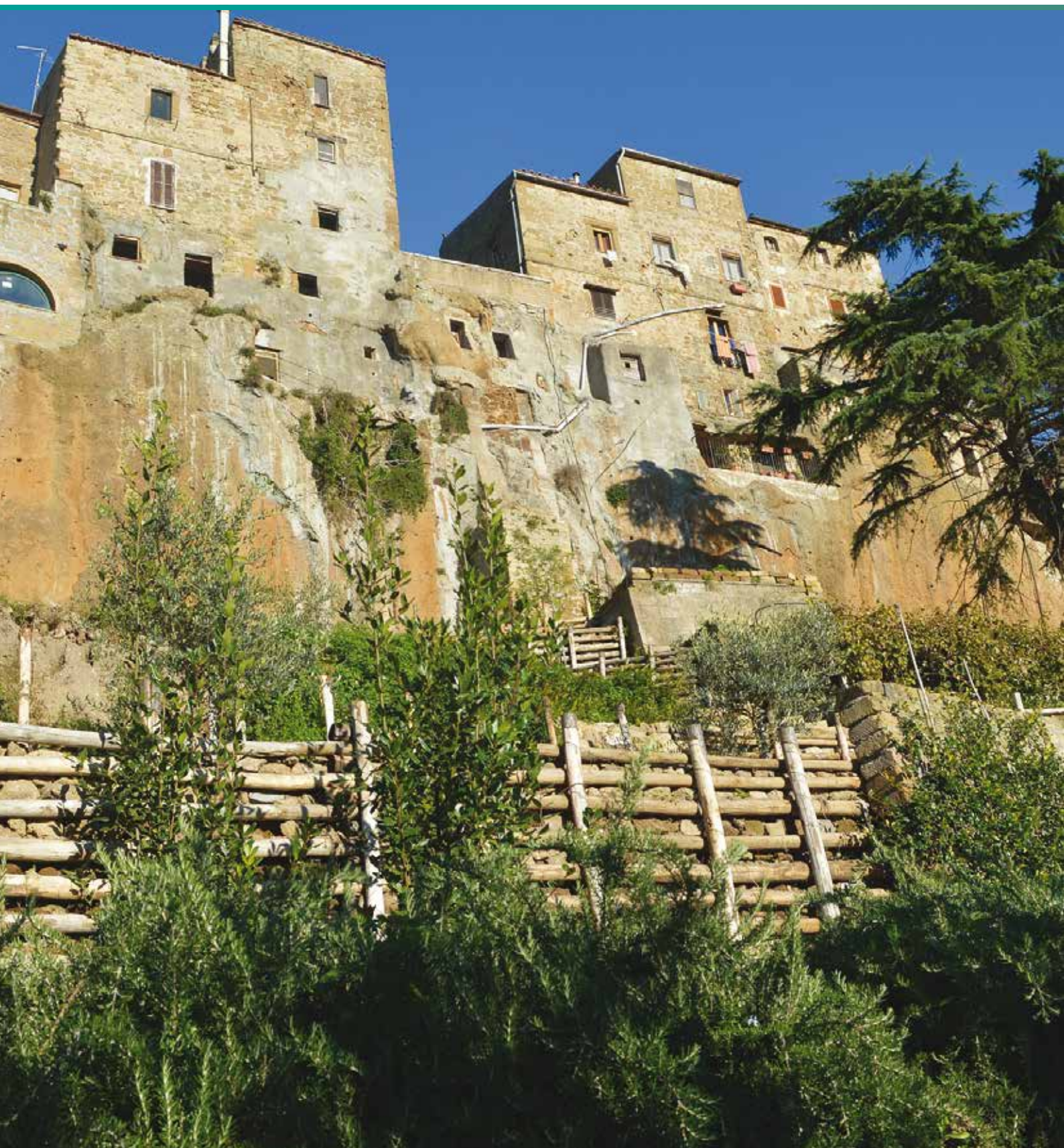
Foto 8.19 Consolidamento rupe tufacea - Intervento 431/02 - Pitigliano (GR) Fonte ISPRA Daniele Spizzichino - Francesco Traversa
