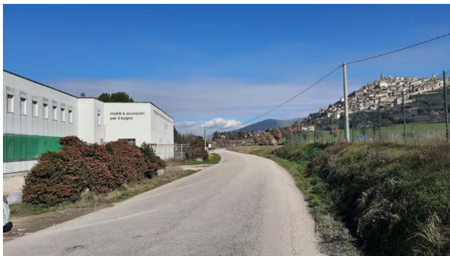
Figura 3 - tratto in direzione punto A: assenza di caditoie, p. ill e marciapiedi
